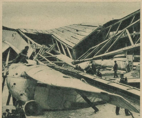
Vom Sturm niedergelegte Flugzeughalle und ein zerstörtes Flugzeug auf dem Tempelhofer Flughafen. Beachtlich für die Leistungsfähigkeit der deutschen Maschinen und die Fähigkeit der Piloten ist, daß während des Sturmes, der diese Schäden anrichtete, drei fahrplanmäßig eintreffende Flugzeuge glatt landeten Fotoaktuell
