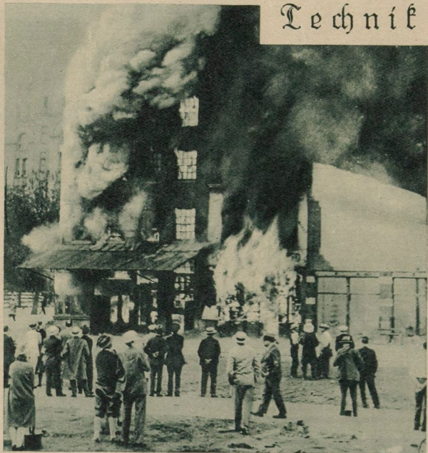
Zum schnellen Abbruch wurde ein fünfstöckiges Haus im Regierungsviertel von Washington angezündet und unter Bewachung der Feuerwehr niedergebrannt. Der „praktische Amerikaner“ nutzte die Hitzeentwicklung gleichzeitig zu Versuchen mit neuen Stahlfassetten aus, die auf ihre Widerstandsfähigkeit gegen Feuer erprobt wurden Wid-World-Photos
