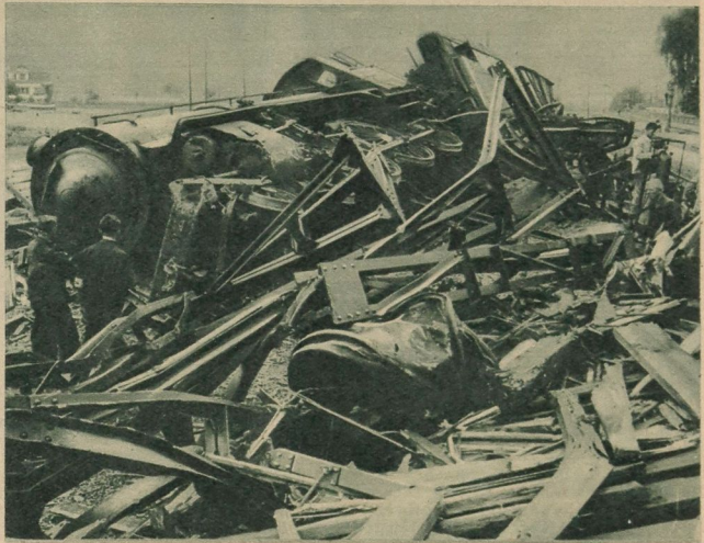
Die Trümmer des bei Dintelscherben infolge falscher Weichenstellung entgleitenen Waggons; die Katastrophe forderte bekanntlich 17 Todesopfer Wismann
