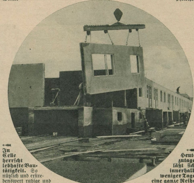
Heutzutage läßt sich innerhalb weniger Tage eine ganze Reihe bewohnbarer Häuser mit gleichen Arbeitskräften herstellen, die früher mehrere Monate dazu gebraucht. Die fabrikmäßig hergestellten genormten Hauswände aus Bimsbeton sollen sich dabei gut bewährt haben. Fehlt nur noch „stellenweise“ das Geld dazu, und die Wohnungsnot ist vorbei. Prof.-Archiv
