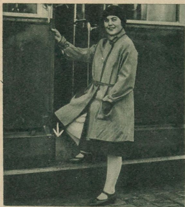
Kein „Aufspringen während der Fahrt“ mehr! Verschiedene Straßenbahngesellschaften sind dazu übergegangen, ihre Wagen mit einer Vorrichtung zu versehen, die das Aufspringen auf die Trittbretter der Wagen während der Fahrt unmöglich macht. Diese Vorrichtung (+) arbeitet gleichzeitig mit dem Öffnen und Schließen der Türen S.B.D.
