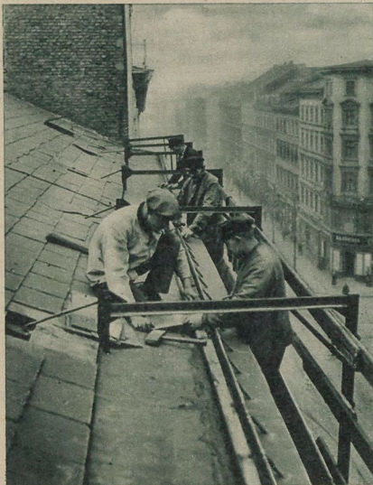
Zum Schutze von Dacharbeitern gelangt jetzt eine neue Art von Bügelgerüsten zur Anwendung. Starke rahmenartig ausgebildete Bügel tragen in Abständen von je 3 Meter Bohlen und Schuttbretter. Sie sichern und erleichtern dadurch die Arbeit Photothek
