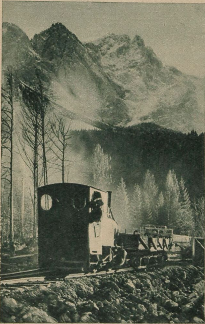
Eine Hilfsbahn zum Bau der deutschen Zugspitzbahn, die vom Eissee aus auf den Gipfel Johannes, Partentischen
