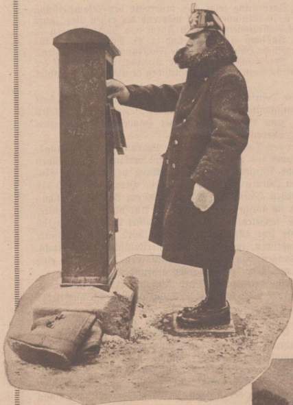
Der Verkehrspolizist auf der Wärmeplatte, ein neues Bild in den verkehrreichen Großstädten während der Kälteperiode. Vor ihm mit der Hand zu betätigender Licht- signalapparat ist eine Standplatte eingelassen, die elektrisch geheizt wird Kochlone
