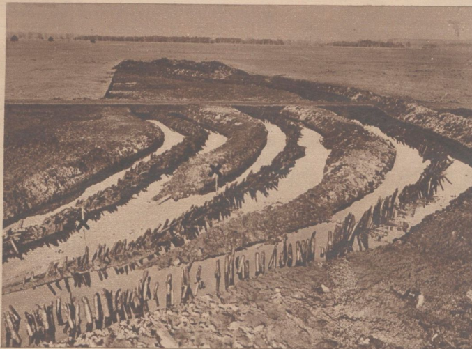
Die dreifache Palfade der Ostseite (Die beiden hellen Stäbe (x) bezeichnen die Fundstelle des Einbaumes)
