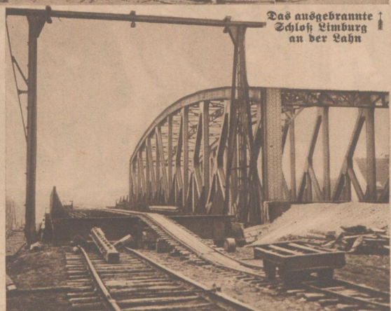
Die neue im Bau befindliche Kanalbrücke im Zuge der belgischen Eisenbahnstrecke Antwerpen-Göhen. Sie wird durch den viergleisigen Ausbau dieser bisher zweigleisigen Bahnstrecke erforderlich, die auch in der Veröffentlichung des Utrechtsch Dagblad (Utrechter Tageblatt) über das französisch-belgische Militärabkommen genannt ist.
