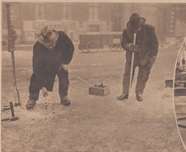
„Die Gaschnüffler“. Zur Kontrolle der infolge der harten Kälte vielfach beschädigten Gasrohre sind jetzt Gasriecherkolonnen organisiert, um die Leitungen zu prüfen. Geheimnisvoll sieht sich ihr Walten an, wenn sie die langen Röhre in die Erde stecken und an der oberen Öffnung riechen Keystone
