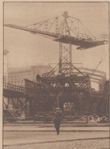
Still und verlassen liegt die Baustelle da
