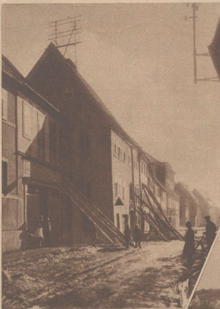
In Frankenberg in Sachsen mußte eine ganze Häuserfront gestützt und die Straße für den Durchgangsverkehr gesperrt werden, weil die Baulichkeiten infolge des starken Frostes große Risse zeigten und einzustürzen drohten Weidner
