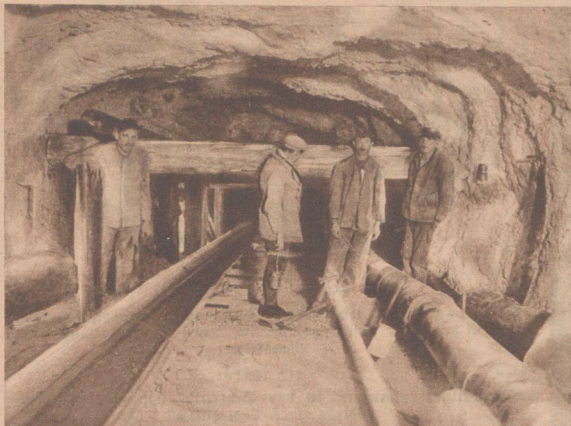
An der Bergstation der zweiten Hilfsbahn, die zum ersten „Fenster“ am Riffelstein hinaufführt. Hier beginnen die Tunnelbauten zur unterirdischen Fortführung der Bahn ← Bild links: Beim Stollendbau am Riffelstein
