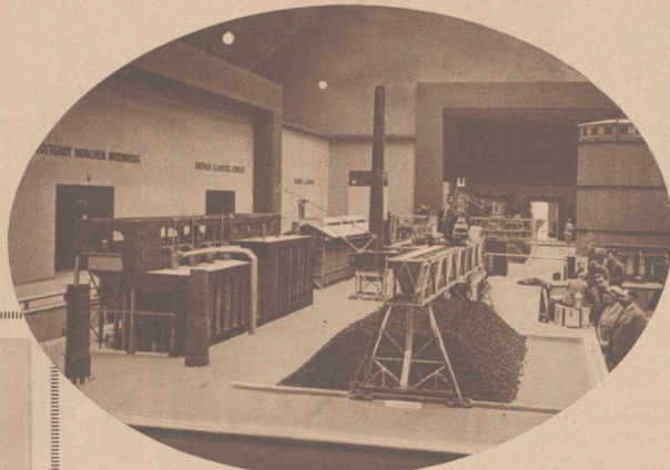
Modell einer Gasanstalt mit allen dazugehörigen Arbeitsvorgängen von der Kokererei durch die verschiedenen Reinigungsstufen bis zum Gasbehälter Senned
