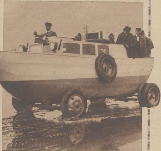
**Auto und Motorboot zugleich!** Ein deutsches Amphibienfahrzeug, das für den Marinefiskus in Cuxhaven erbaut wurde. — Bei der Abnahmefahrt im Watt. Tiedemann
