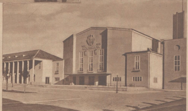
Zur Förderung aller grenzdeutschen Bestrebungen und zur Erhaltung deutscher Kulturgüter wurde das „Reichsdankhaus“ in Schneidemühl erbaut und am 6. Oktober eingeweiht. Hierdurch hat das Reich der Bevölkerung der Grenzmark, vor allem der neuen Provinzialhauptstadt, besondere Förderung erweisen wollen S. B. D.
