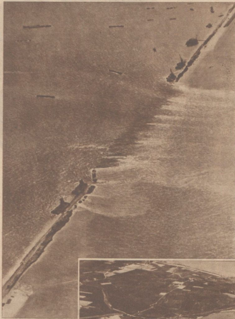
Der Deich am Nordwest-Polder etwa 14 Tage vor der Abschließung des 20000 Hektar großen Wieringermeeres
