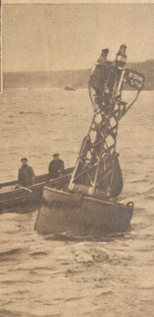
Bild unten: Die Leuchtbojen längs der Küste müssen trotz Kälte und Sturm nachgesehen und ausgebessert werden, um gerade in der für die Schifffahrt schwierigen Zeit nicht zu versagen ↓
