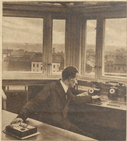
Die erste Lichtwarte wurde in Berlin geschaffen mit dem Zweck, die Beleuchtung der Weltstadt den jeweiligen Lichtverhältnissen anzupassen. Die in 50 Meter Höhe errichtete und mit feinen Mechanismen ausgerüstete Station arbeitet in den Stunden um Sonnenuntergang und aufgang und sorgt für genügende, aber nicht übertriebene Straßenbeleuchtung Atlantic
