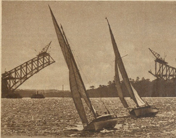
Die mächtige Eisenbrücke über den Hafen von Sidney wächst allnächtlich empor. Sie wird nach Fertigstellung die größte und infolge der hohen Arbeitslöhne in Australien voraussichtlich auch die teuerste Stahlbrücke der Welt sein. — Abend und feierliche Ruhe in dem Sidneyer Hafen
