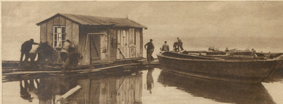
Eine ganze „Laubstadt“ zieht um. Da das Gelände der Kolonie an den Havelbergen in der Mark Brandenburg anderweitig verwandelt werden sollte, mußte jeder „Grundbesitzer“ mit seinem „Haus“ umziehen. Auf Baumstämmen wurden die Lauben zum Wasser gerollt, wo ein Schleppzug von Rähnen eine nach der andern aufnahm und ihrem neuen Bestimmungsort zuführte. Sennede
