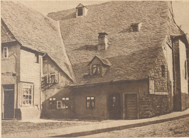
Bild links: Eine alte Bergmannskapelle in Goslar, die zu Kleinwohnungen ausgebaut wurde
