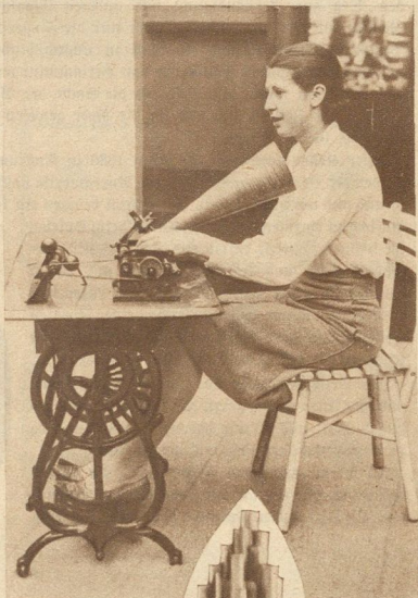
Der Urhahn des heutigen Grammo- phons: Der erste Edison-Phonograph mit Fußantrieb Ceneca
