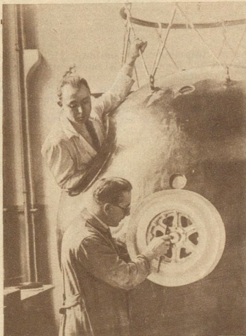
Zum Aufstieg in 16 Kilometer Höhe. Zur Nachprüfung seiner theoretischen Berechnungen will der belgische Professor Piccard selbst in einem wasserstoffgefüllten Ballon in die Stratosphäre aufsteigen. Der „Ballonkorb“ ist eine geschlossene Kugel aus Aluminium. — Piccard mit seinem Assistenten bei den Vorbereitungen Schirmer
