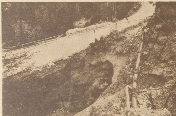
Große Erdbinbrüche in Oberbayern. In der Nähe von Berchtesgaden kam es zu erheblichen Erdbinbrüchen, die die neue Straßenbrücke zum Oberalzberg gefährdeten. — Eine trichterartige Öffnung von etwa 15 Meter Durchmesser an der Straße Berchtesgaden — Oberalzberg — Atlantic
