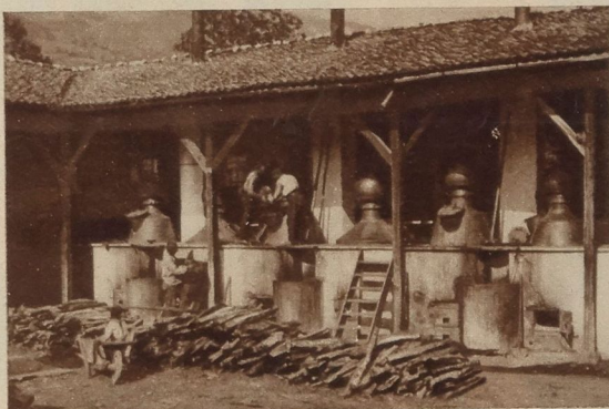
← Eine ältere Rosenöl-Destillations- anlage noch mit direkter Feuerung
