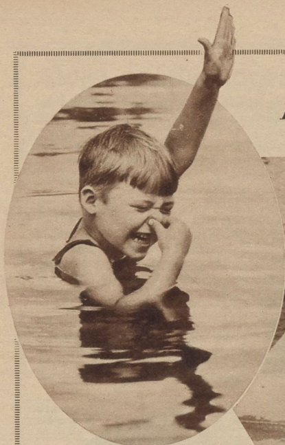
Bei 30 Grad tut ein kühles Bad gut
