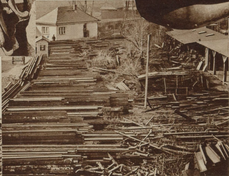
Wohlgeordnet harren die ausgeordneten, noch brauchbaren Teile, hier Eisenbahnen und Röhre, neuer Verwendung
