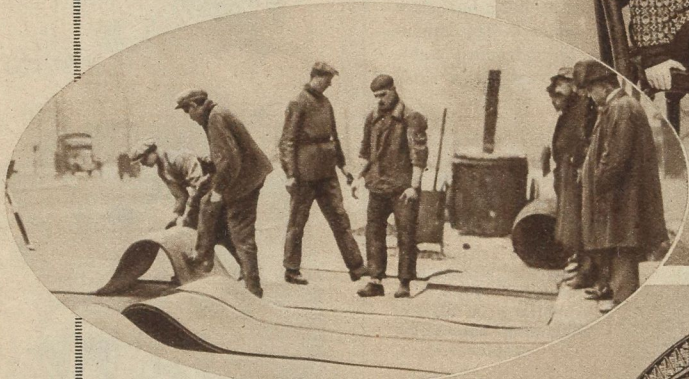
Gummitteppiche als Straßenpflaster. Um das gefährliche Gleiten der Autos auf dem nassen Asphalt zu verhindern, deckt man das Straßenpflaster mit langen Bahnen von Gummitteppichen, die durch Teer miteinander verbunden werden. S.
