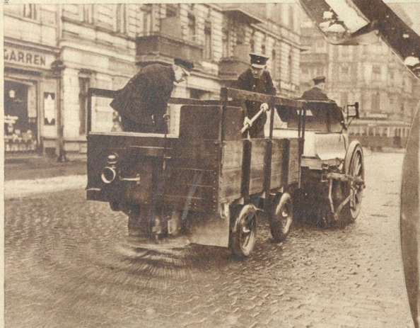
Kampf dem Glatteis. Ein kreifendes Rad streut den im Wagen aufgespeicherten Sand fein verteilt über die halbe Straßenbreite, so daß der großstädtische Damm dem Verkehr wieder gewachsen ist. R.
