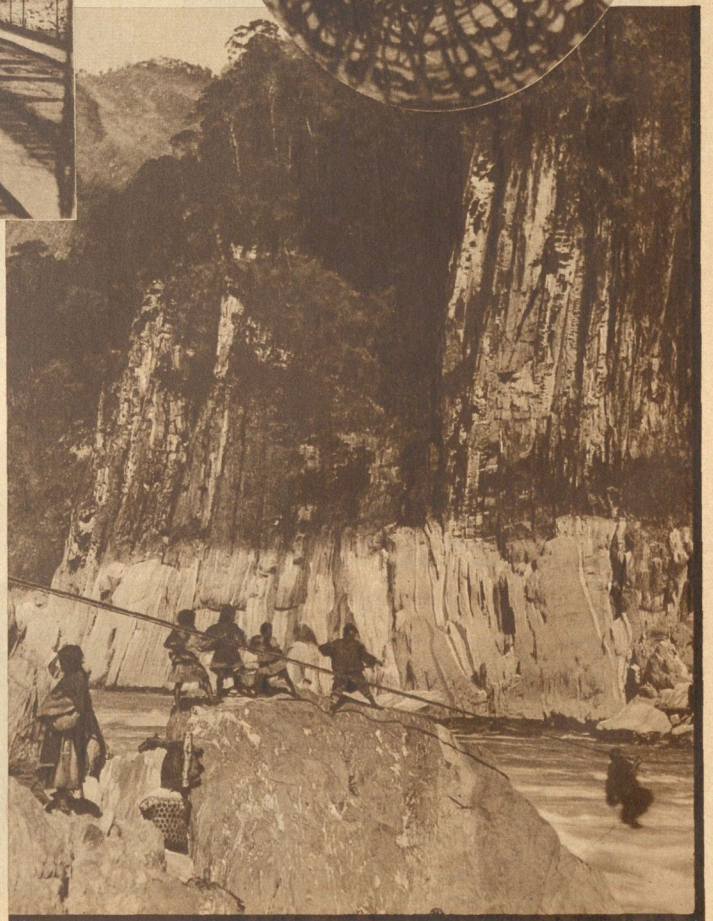
→ Röhren- förmige Brücke aus Manilla- rohr über den Dhang- Fluß in Hinter- indien. Die Brücke ist auf beiden Ufern an den Bäumen be- festigt Maurtius
