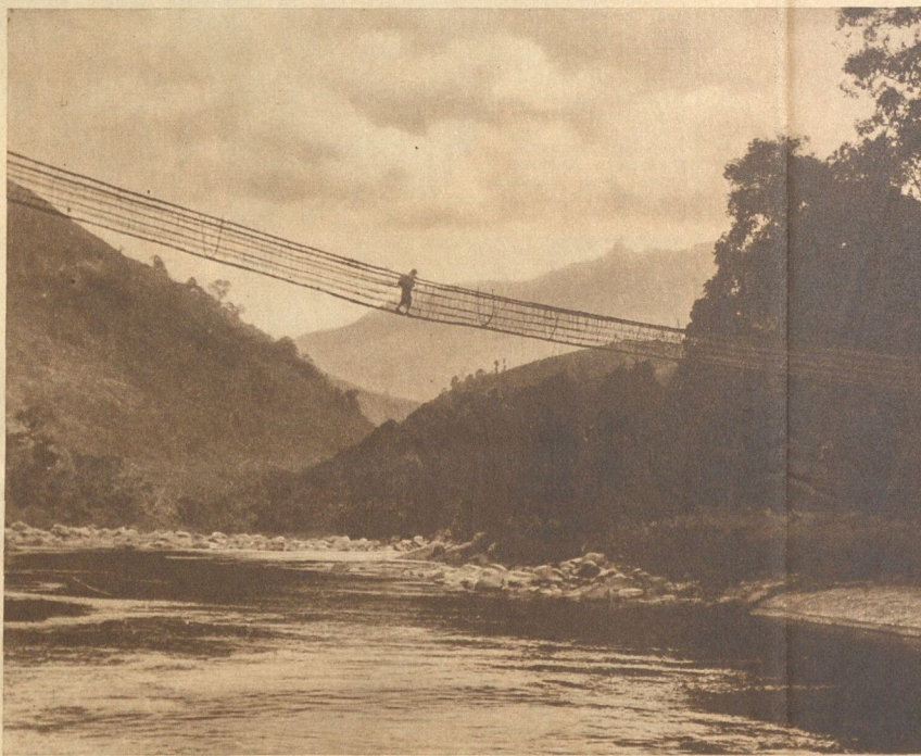
Über reisende Flüsse, die oft Hochwasser führen, sind leichte Hängebrücken die sichersten Verkehrswege. Sie lassen sich leicht ab- und aufbauen und sind von außerordentlicher Haltbarkeit.
