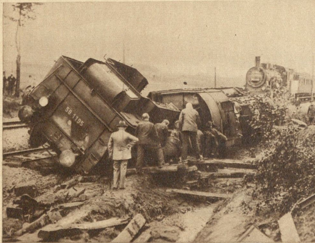
Unten: Schwere Schäden durch Wolkenbrüche in Thüringen. Der andauernde Regen der letzten Wochen hat an einzelnen Stellen zu erheblichen Überschwemmungen geführt. So wurde z. B. die Eisenbahnstrecke zwischen Hermsdorf und Stadtroda unterpflut, wodurch ein Güterzug entgleiste
