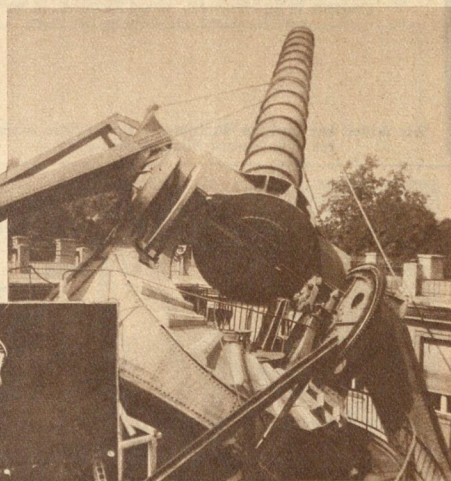
Der 21-Meter-Refraktor der Treptower Sternwarte (Berlin). Das Objektiv des in seinen Ausmaßen gewaltigen Rohres hat einen Durch- messer von 68 Zentimeter
