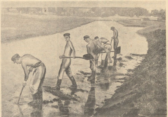
Freiwillige eines Stahlhelm-Arbeitslagers (Hilfsregulierungsarbeiten in Schlesien).
