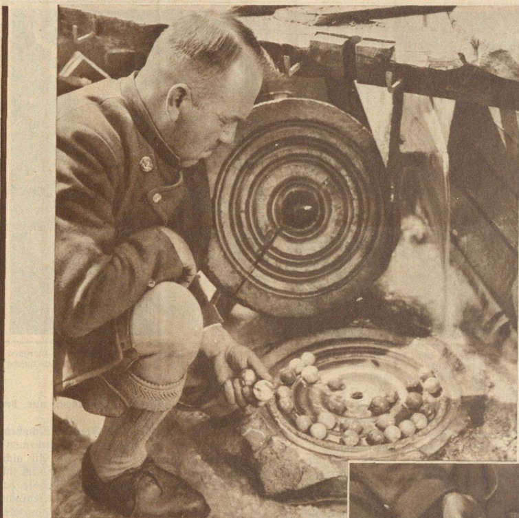
Der Kugelmüller hat eine der Mühlen aufgedeckt. Der obere Buchenholzdeckel mit den Turbinenschaufeln auf der Oberseite ist zurückgeschoben, so daß die Kugeln in den Rillen des Steinblocks zur Prüfung frei liegen
