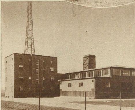
Der neue Breslauer Telefunken-Großsender mit Antennenturm und Kühlturm. Bemerkenswert ist die Ginturm-Antenne, die konstanten Empfang ohne den störenden Wellenschwund und die dadurch verursachte Schwankung in der Tonstärke sichert. Sie besteht in einem senkrechten Kupferdraht, der im Innern eines Holzturmes hochgeführt ist und oben in einem Bronzering endet. Dieser Holzturm ist der höchste der Welt
