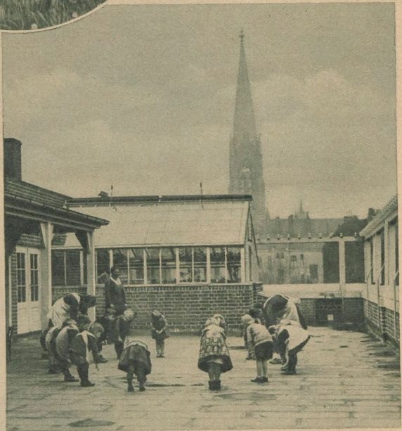
Kinderturnen auf dem Dachgarten. Auch in der Großstadt läßt sich Gelegenheit schaffen, die Kinder möglichst viel im Freien zu halten. Wie ↑ dies Bild vom Neubau des Berliner Pestalozzi-Fröbel-Hauses zeigt, lernen hier die zukünftigen Kindergärtnerinnen und die Hauswirtschafts-schülerinnen für die kleinen Gäste zu sorgen, die sonst heute, wo vielfach auch die Mütter auf Erwerb ausgehen müssen, aufsichtslos bleiben würden. So wird in den jungen Mädchen frühzeitig das Verantwortungsgefühl gegenüber den Kindern geweckt Photothef
