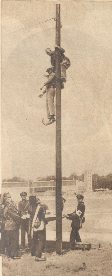
Ein vom Starkstrom Getroffener wird vom Mast herabgelassen und geborgen. Sennede
