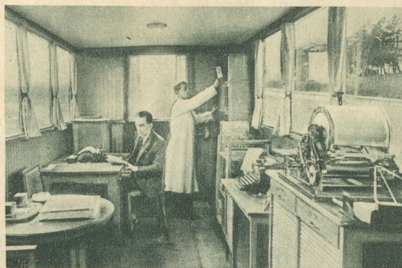
Eine fahrende Werkstätte für Schreibmaschinen-Reparaturen in einem eigens hierzu erbauten Kraftwagen ist von einer Münchener Firma für den Gildienst auf dem Lande eingerichtet worden Phot. Wipro
