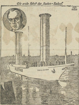
Das Flettner'sche Windkraftschiff „Baden-Baden“ ist von Kiel aus zu einer Fahrt über den Ozean aufgebrochen. Im Kreis: Anton Flettner.
