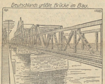
Deutschlands größte Brücke im Bau. Nach zweijähriger Bauzeit geht jetzt zwischen Hämerten und Schönhausen die neue Elbbrücke ihrer Vollendung entgegen. Ihre Gesamtlänge beträgt 810 Meter.
