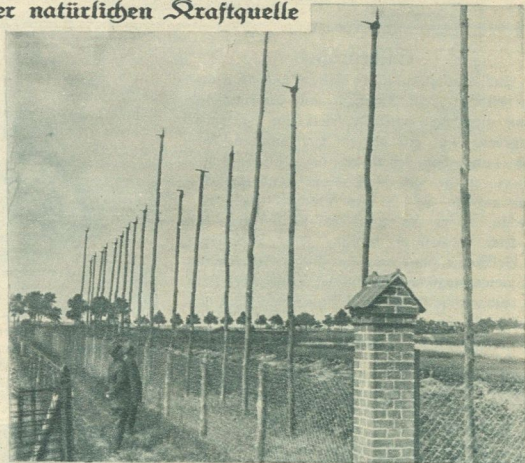
Bild rechts: Die als Antennen wirkenden Masten an den Versuchsfeldern. Phot. Verlag
