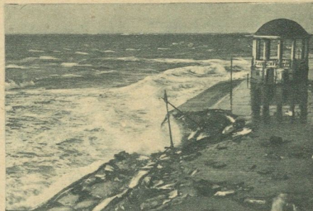
Von schweren Sturmschäden wurden die deutschen Nordseeinseln und einige Häfen, so Hamburg, heimgesucht. Der heftige Nordweststurm trieb die Flut teilweise über die Schutzdämme und zerstörte sie. In Borkum (oben) wurden die Strandmauer eingerissen und die Kuranlagen bedroht. Phot. Wessels, Borkum
