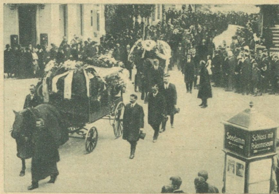
Beisehung der Eisenbahner , die durch den Unglücksfall im Ricken zu nnel auf der Strecke St. Gallen-Zürich ums Leben kamen. Die gesamte Belegung eines Güterzuges und die ausgefandte Mannschaft, insgesamt neun Menschen, erstickten an giftigen Gasen. Phot. Oros
