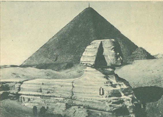
Die Cheops-Pyramide als Radiostation. Auf der weltberühmten, von König Cheops um 2400 vor Christo erbauten Pyramide bei Gizeh (Cairo) wird jetzt in 160 Meter Höhe eine Sendeanlage errichtet. Die Sendeapparate selbst sollen in der früheren Grabkammer des Königs untergebracht werden. Phot. Kester & Co.
