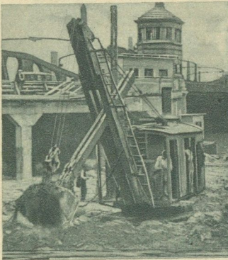
Eine Dampfschaufel, die stündlich etwa 30 t Schutt beseitigt
