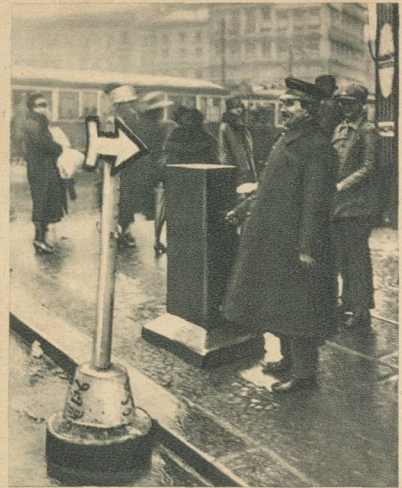
Die elektrische Weichenstellung wurde als neueste Erfindung bei der Straßenbahn der Reichshauptstadt eingeführt. Ein Hebelautomat richtet die Weichen vom Bürgersteig aus, so daß für den Fahrer Zeit erspart und eine Gefahrenmöglichkeit für den Weichensteller ausgeschaltet wird. Die erste derartige Anlage befindet sich auf dem neu umgebauten Spittelmarkt. Phot. Press Archiv
