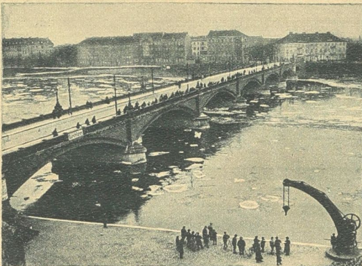
Die Oberbrücke in Frankfurt wurde ernstlich gefährdet. Infolge des hohen Wasserstandes fuhr ein mit 8000 Zentner Kohle beladener Kahn gegen einen Brückenpfeiler, wurde leck und sank. Erst die Sprengung des Bootes machte der Schiffsahrt den Weg wieder frei, jedoch wurden Brückenpfeiler beschädigt Phot. Sennet
