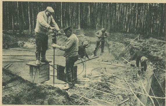
Deutschlands fortschreitende Entwaffnung: Anlegen von Bohrlöchern mittels Preßluftbohrer für die Sprengladung, durch die die ehemaligen Feuerwerke der Kommandantur Küstrin (etwa 80 Kilometer von der polnischen Grenze) vernichtet werden. Photothek
