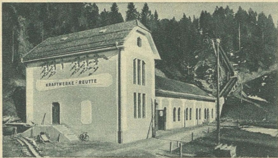
Das Kraftwerk und ein Maschinenraum (rechts)
