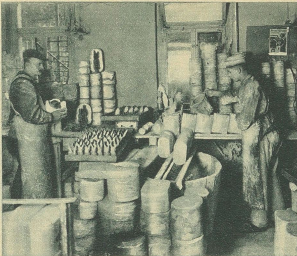
Ausgießen der Formen, links Entfernen der Formhülle
