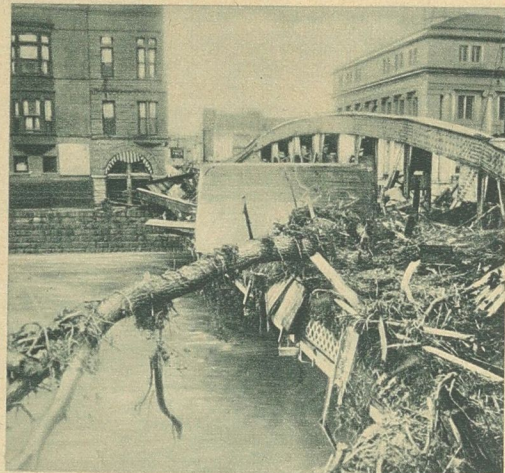
Die verheerende Wirkung der Fluten des Mississippi kam nach Sinken des Wasserpiegels zur Geltung, als die angeschwemmten Trümmer sichtbar wurden. Press-Photo
