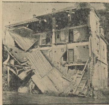
Überreste der durch das Hochwasser zerstörten Häuser in Vergießhübel.
