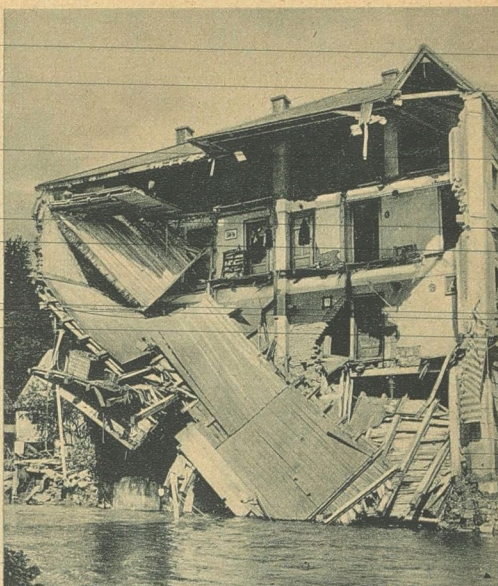
Ein dreistöckiges Haus in Berg-Gieß- hübel, das zur Hälfte fortgerissen ist: die herabhängenden Flächen sind die Fuß- böden der Zimmer Photo-Union
