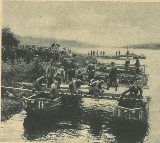
Von den diesjährigen Reichswehrmännern. Bau einer Pontonbrücke über die Saale. Phot. Wide World
