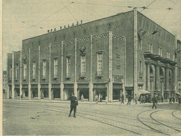
Ein Lichtspielhaus wurde auf dem Gelände des alten Stuttgarter Hauptbahnhofes erbaut. Beachtenswert ist, daß die Rundbogen des Bahnhofseinganges (auf dem Bilde rechts) bei dem Neubau verwertet wurden Photothek
