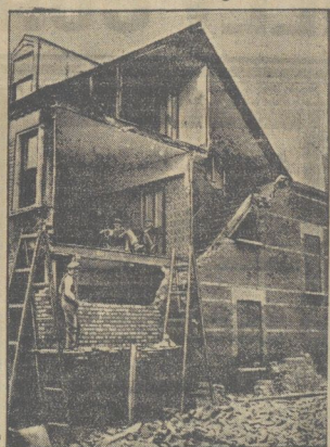
Infer Bild zeigt ein Haus in London, dessen Giebelwand durch den Sturm umgestürzt. Zwei Personen wurden durch die niederfallenden Trümmer getötet.
