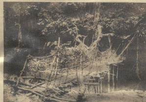
3. Brücke im Urwald bei Lume in Kamerun
