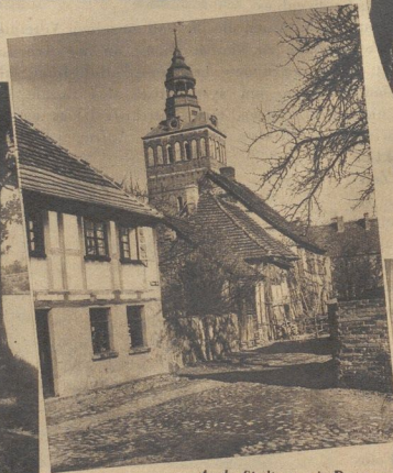
An der Stadtmauer in Drossen
