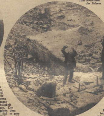
Kreis: Steinbrecher schlagen Löcher zum Abstreifen des Eisens
